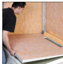
ad 3. Zasunutí spádové desky pod těleso žlabu
