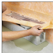
ad 2. Osazení tělesa žlabu
