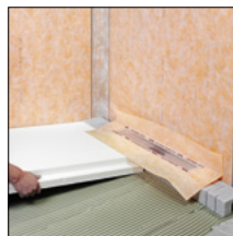
ad 3. Položení vyrovnávací desky do roviny
