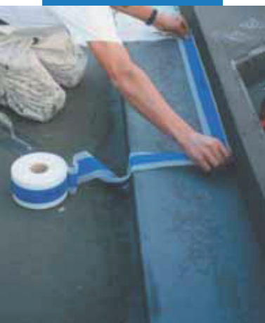
Príklad utesnenia rohu vzniknutého medzi dnom a stenou bazény použitím pásu Mapeband.
