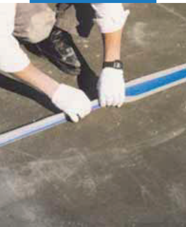
Príklad utesnenia proti vode v mieste dilatlačnej škáry na terase.
